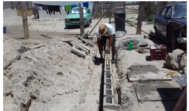
Der Baubeginn im Dezember 2016
