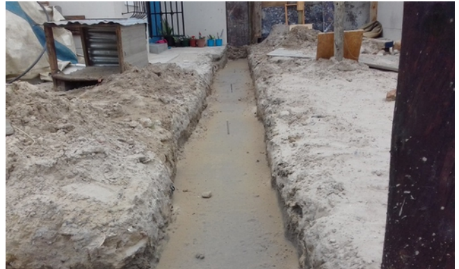
Beginn der Bauarbeiten – die Fundamente (Dezember 2016)
